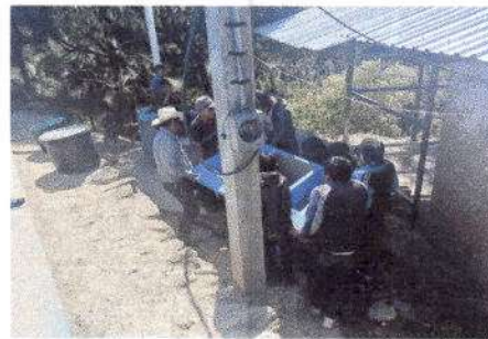
Foto 6: Sustitución de pila por 2 lavaderos
