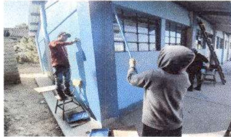
Foto 4: Sustitución de pintura en muros interiores y exteriores
