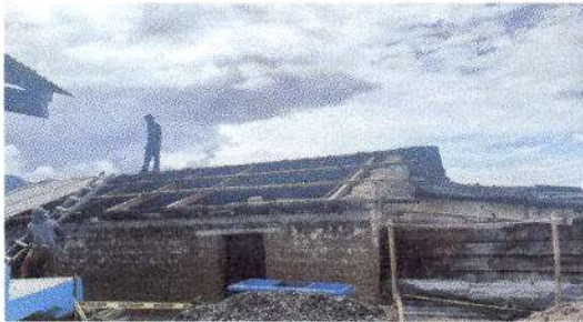
Foto 3: Sustitución de lamina por lamina troquelada
