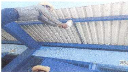
Foto 5: Sustitución de focos LED
